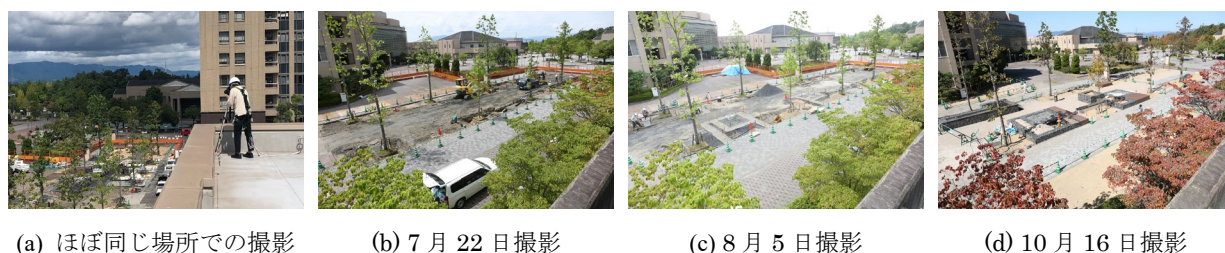
図6 屋上からの準定点観測による工事区間の俯瞰画像
